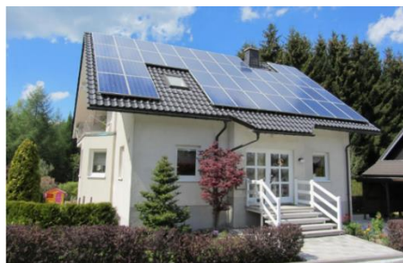
Figura 1- Painéis fotovoltaicos como material de revestimento arquitetônico.
