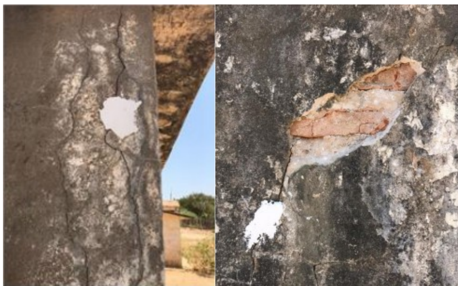
Figura 3 – Aplicação de gesso em fissura (à esquerda) e abertura de janela de inspeção (à direita)
